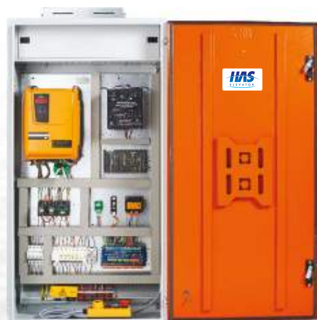
Станция управления HAS VVVF с доводчиком
