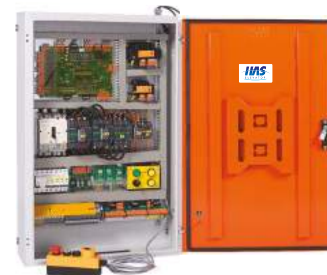
Гидравлическая станция управления
